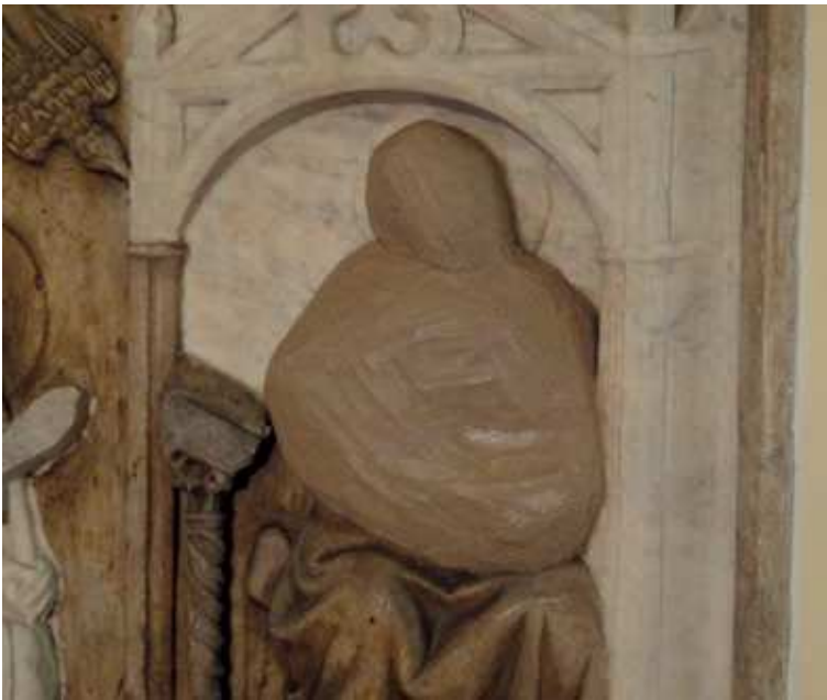
Alcune fasi del restauro
