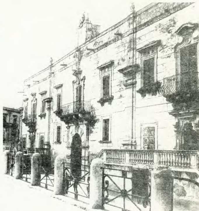
Palazzo Filangeri Cutò a Santa Margherita Belice, prima del terremoto del 1968.
