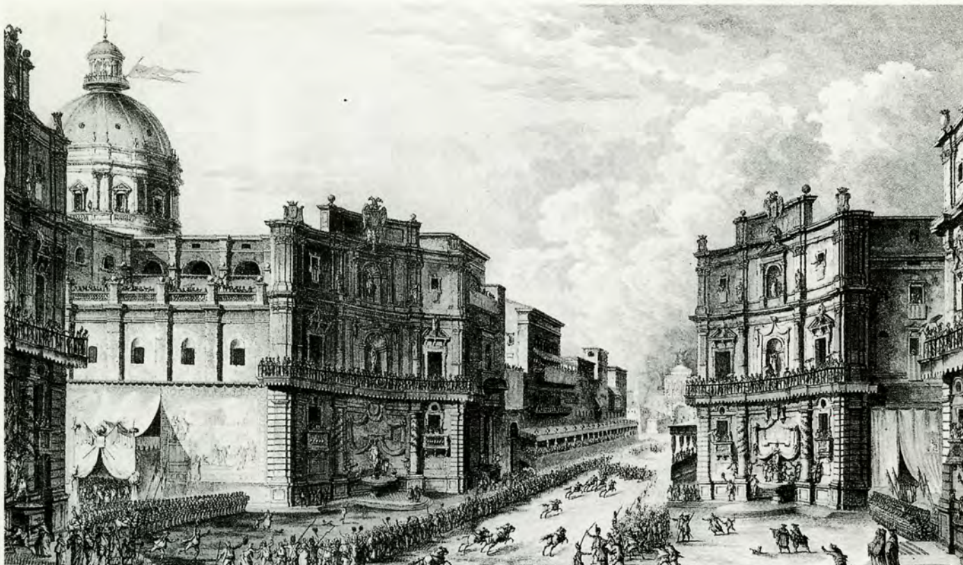
I "Quattro Canti" da un'incisione di Louis Jean Desprez del 1785. Addossata al cantone di Santa Ninfa, la chiesa di San Giuseppe dei Teatini, in angolo fra le strade del "Cassaro" e "Maqueda"
