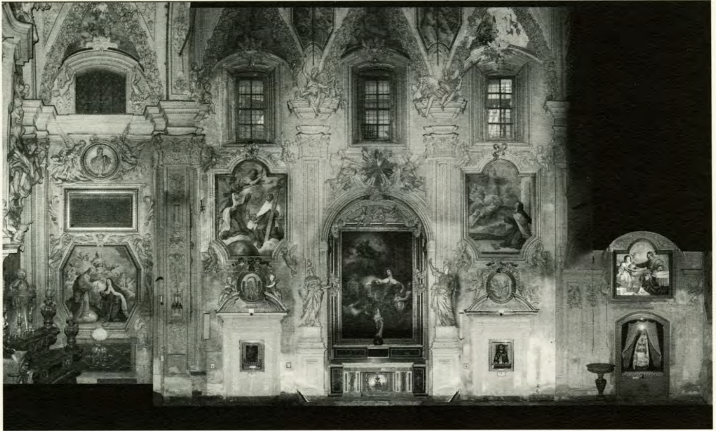
Rilievo fotogrammetrico della parete destra e del pavimento, eseguito dalla Soprintendenza per i Beni culturali ed ambientali di Palermo
