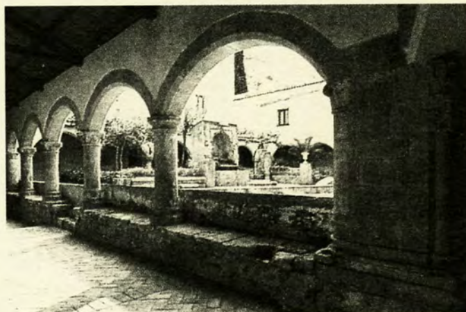
Convento di Santa Maria di Gesù, portico e portale della Chiesa
