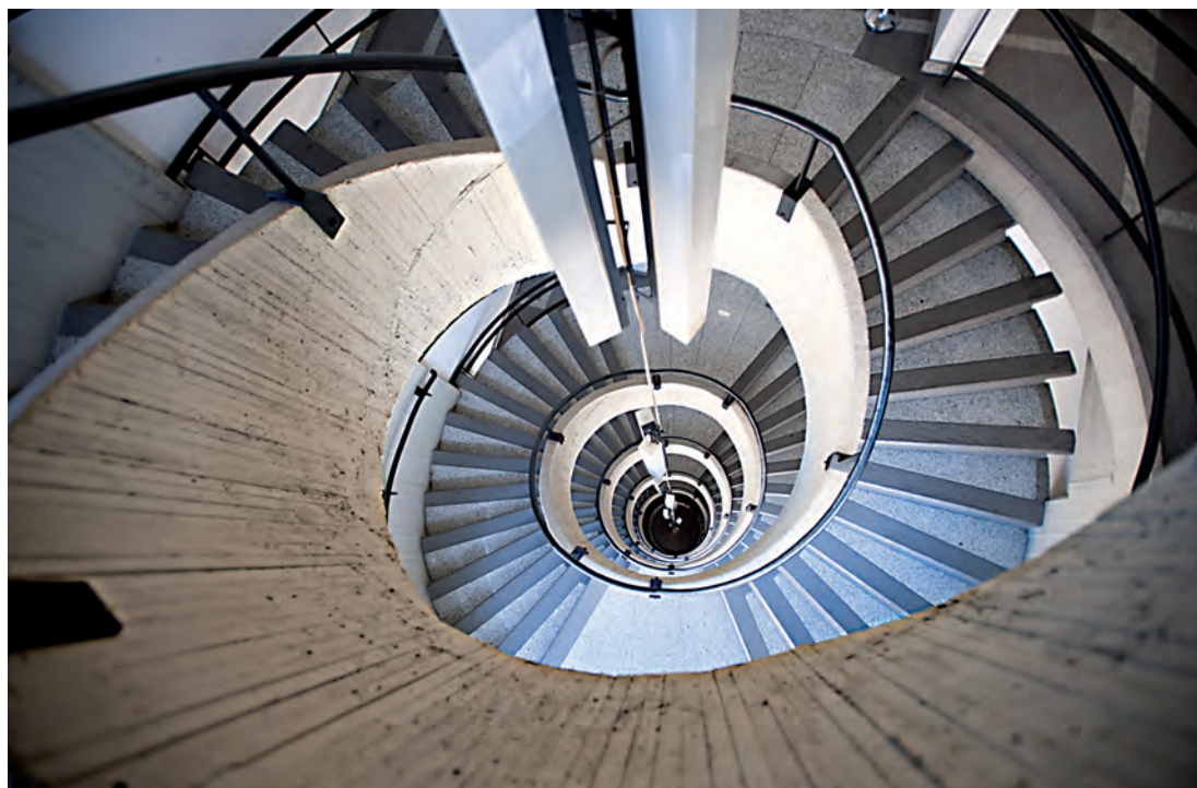
La scala elicoidale con struttura in cemento armato a vista Foto Andrea Ardizzone
