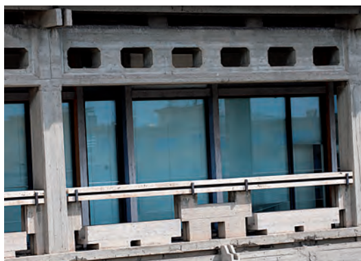
Particolare del prospetto su via Marchese di Villabianca visto dall'alto
