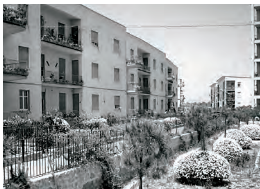
Veduta aerea del quartiere in fase di costruzione (Archivio Luigi Epifanio)
