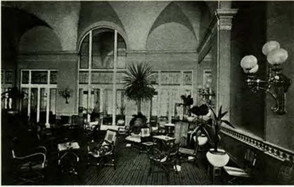
Palazzo Larderìa, corso Vittorio Emanuele due vedute del salone d'ingresso
