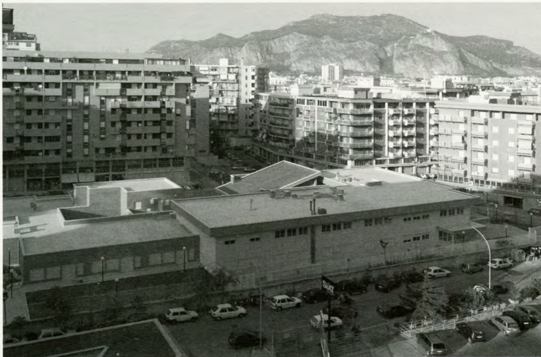
Scuola elementare e media Giuseppe Verdi appena costruita ma non ancora fruibile, in via Casella. La grande spianata di tetti si presterebbe benissimo ad essere convertita in tetto-giardino. (foto di Andrea Ardizzone)
