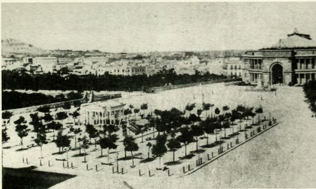
Nella fotografia realizzata durante la costruzione del Teatro Politeama (1890) sono evidenti i giardini di Radaly, sacrificati per la lottizzazione conseguente all'apertura della Strada della Libertà A sinistra: una fotografia del 1885 (studio Incorpora) intitolata "veduta del Giardino Inglese"
