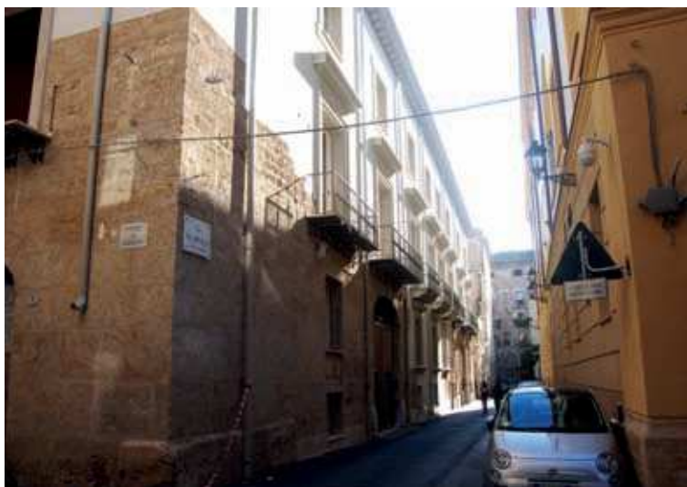
Prospetto su via Lampedusa, prima-dopo
