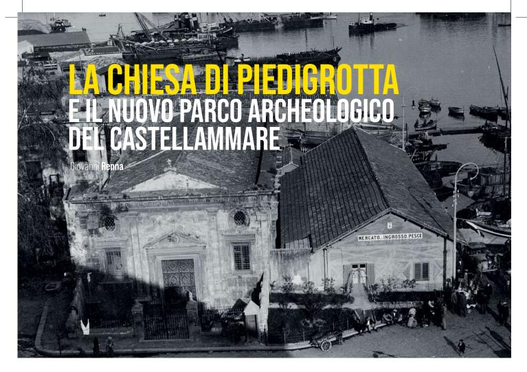
La chiesa e il mercato in una foto probabilmente della seconda metà degli anni 30. Il capannone è' già stato ampliato abusivamente dal Comune: il tetto è completamente addossato, per l'intera lunghezza, al prospetto meridionale della chiesa ed è stato realizzato all'estremità orientale un nuovo piccolo corpo di fabbrica.
