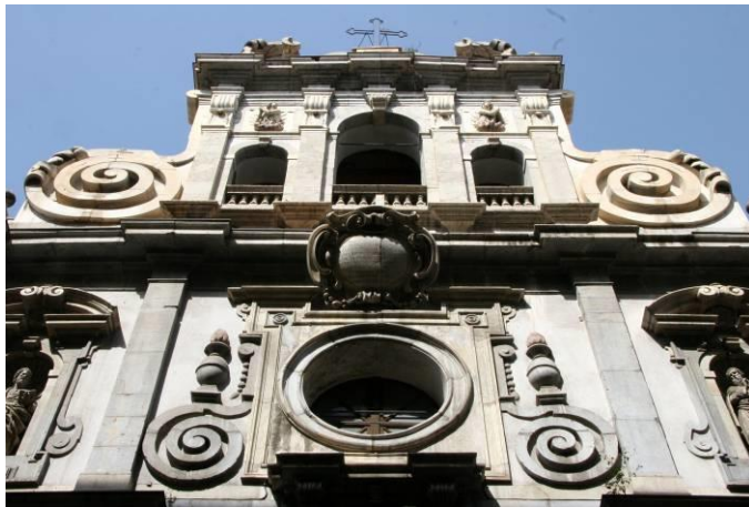
Chiesa di San Matteo. Particolare del prospetto (1662). Se il progetto iniziale si deve a Mariano Smiriglio il prospetto è opera di Carlo D'Aprile e Gaspare Guercio. Il prospetto è interamente rivestito in Billiemi. All'interno sono realizzate pure in Billiemi le colonne che scandiscono le navate laterali.
