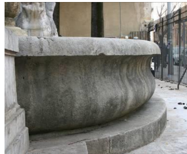
Fontana dei Draghi. Particolari a confronto. A sinistra la conca nel disegno di Mariano Smiriglio, a destra la conca oggi. I due scalini con toro che sostengono la conca sono stati sostituiti da una semplice base retta che contorna anche il basamento su cui insistono i Draghi alterandone la dimensione in altezza..
