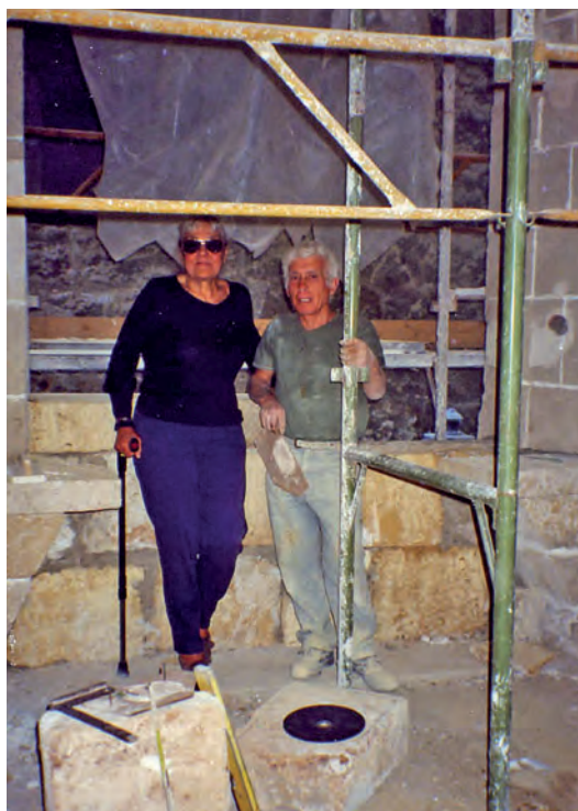
L'architetto Braida sul cantiere di Palazzo Rostagno
